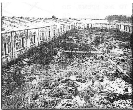
ЗАО «Восход» до реконструкции
