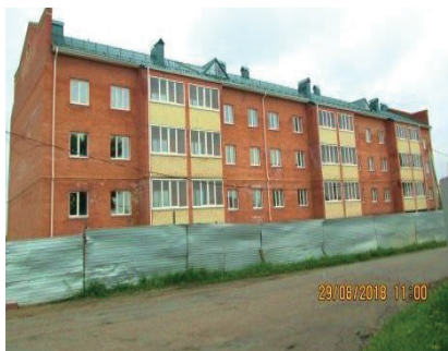
Многоквартирный жилой дом в р.п. Муромцево
