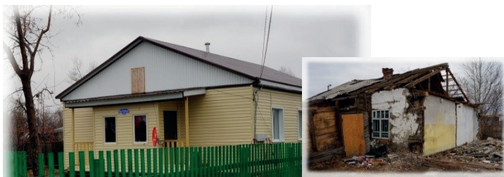
Построенный дом взамен аварийного в с. Ульяновка
