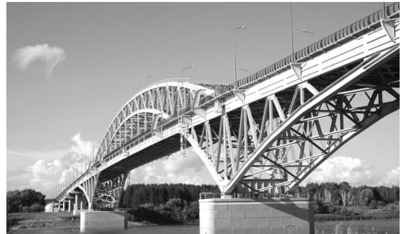
✓ В Тарском районе завершено строительство 700-метрового Самсоновского моста через Иртыш. Впервые в практике российского мостостроения спроектировать, изготовить металлоконструкции и осуществить их монтаж по своему же проекту удалось силами одной организации – НПО «Мостовик»
